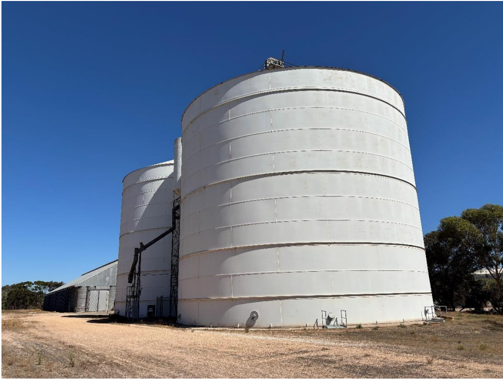
Steel vertical silo.
