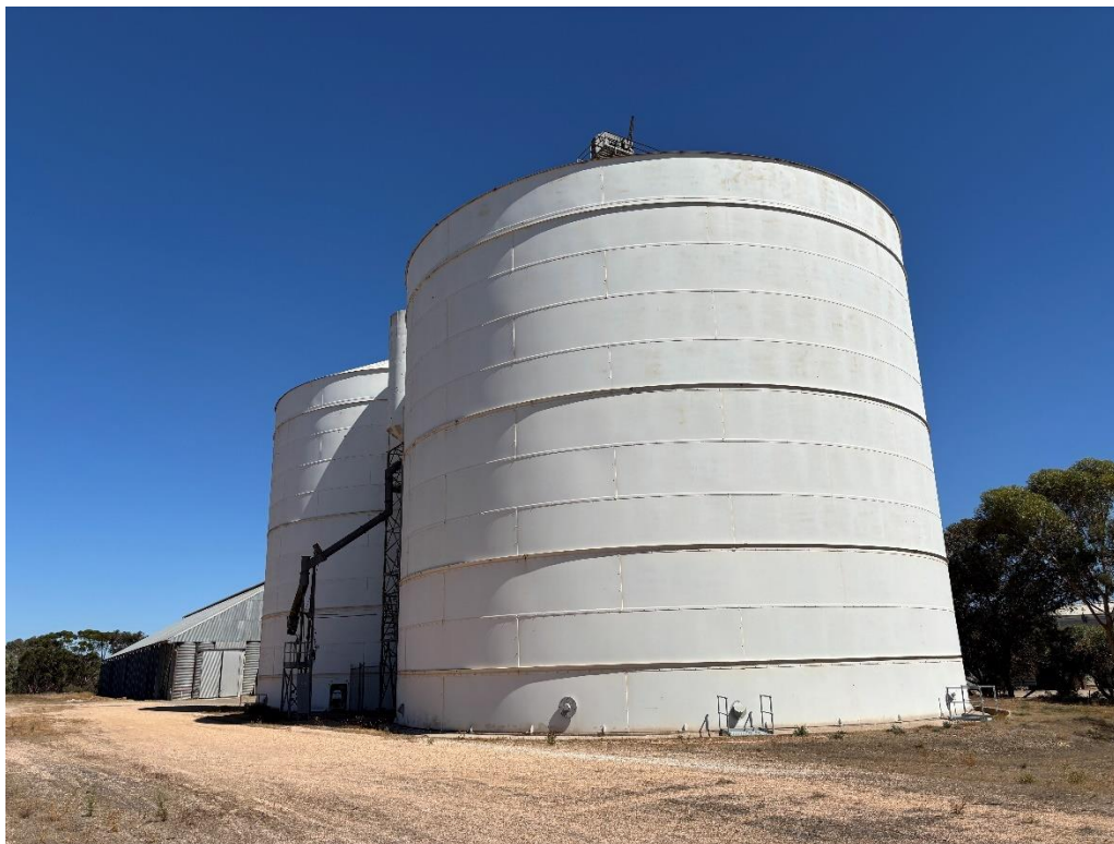
Steel vertical silo.
