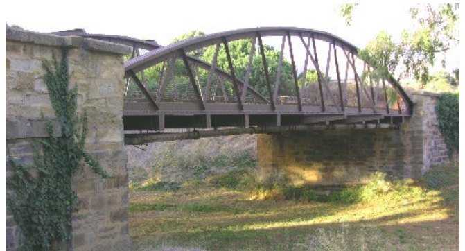
Above: Kooringa Bridge DEW 2024
